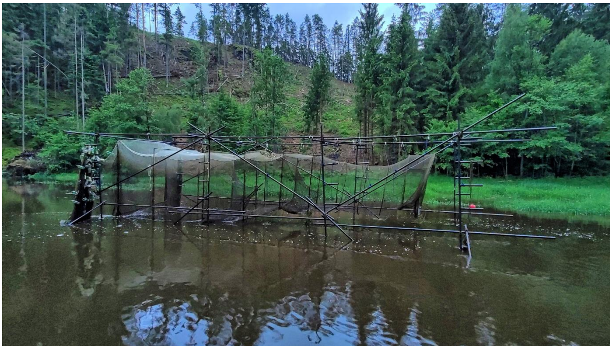
Foto 5 Příprava vězence na zvýšený povodňový průtok. Vězenec kompletně vytažen nad vodní hladinu včetně složení a zavěšení naváděcích síťových ramen vězence na pevnou vnější konstrukci.
