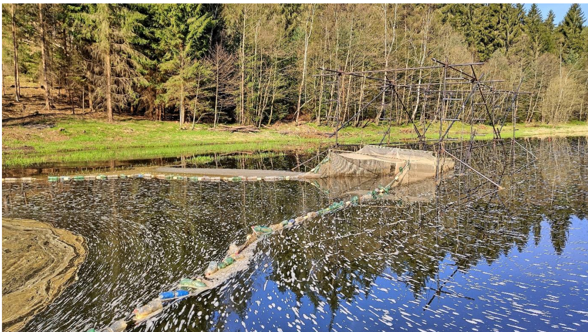
Foto 2 Detailní pohled na přehrazení přítokové části nádrže (ÚN Římov) vězencem s pevnou vnější konstrukcí.
